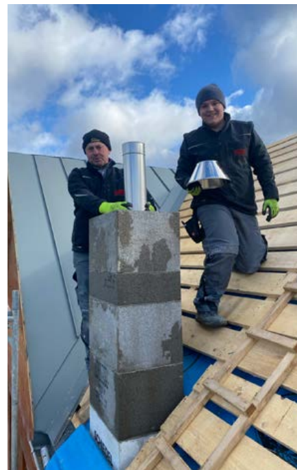
Das Ignis-Team sorgt für einen reibungslosen Ablauf der Kaminsanierung.
